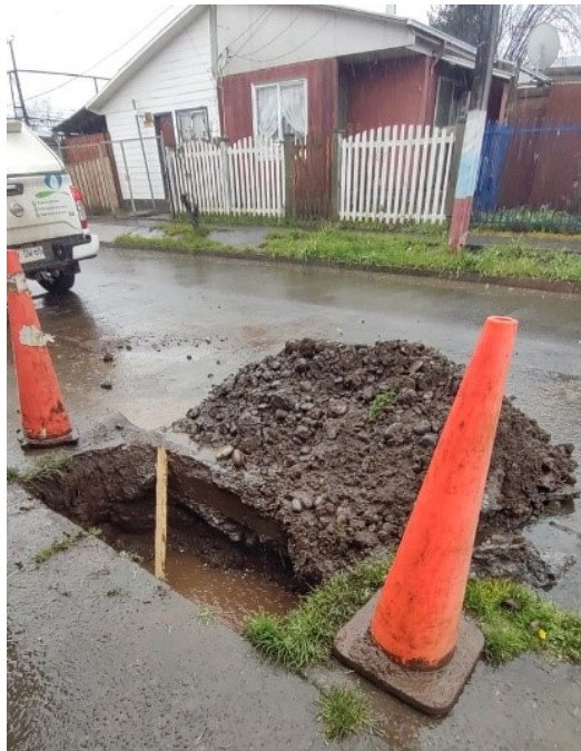
Excavación por ruptura de matriz en octubre de 2024.
